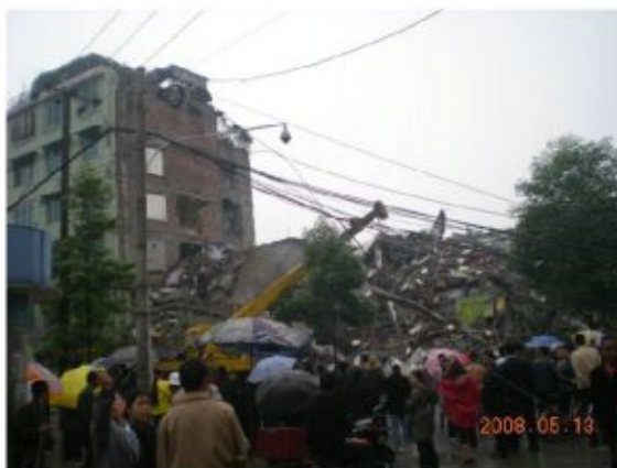
崩壊した聚源中学校
